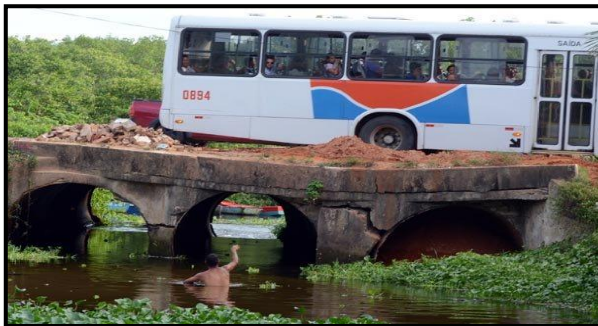
Figura 4 - Ponte sobre o Rio Doce na Avenida Doutor João Medeiros Filho. Fonte: ABREU, 2016.
