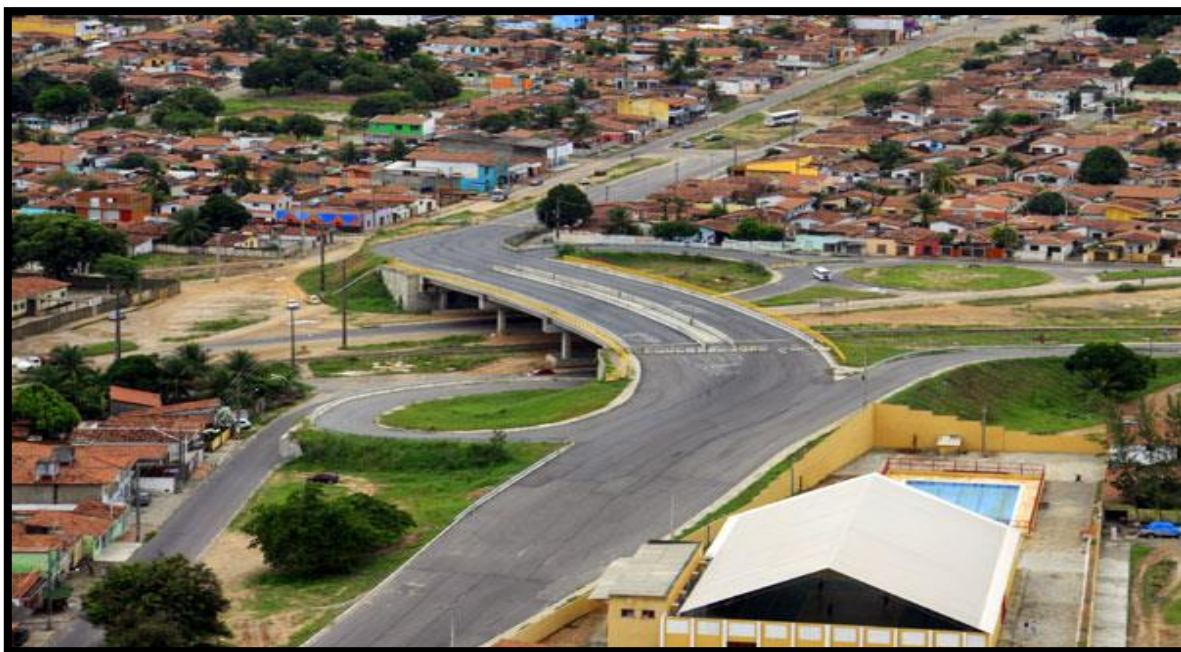
Figura 6 - Viaduto do Conjunto Habitacional Santa Catarina.
