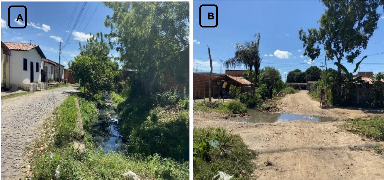
Figura 2 – Ocupações em áreas suscetíveis a inundações sazonais na Zona Norte de Teresina
