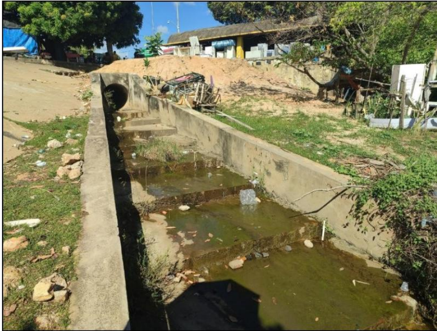
Figura 8 – Galeria de água pluviais à margem do Rio Parnaíba, Teresina, Piauí.
