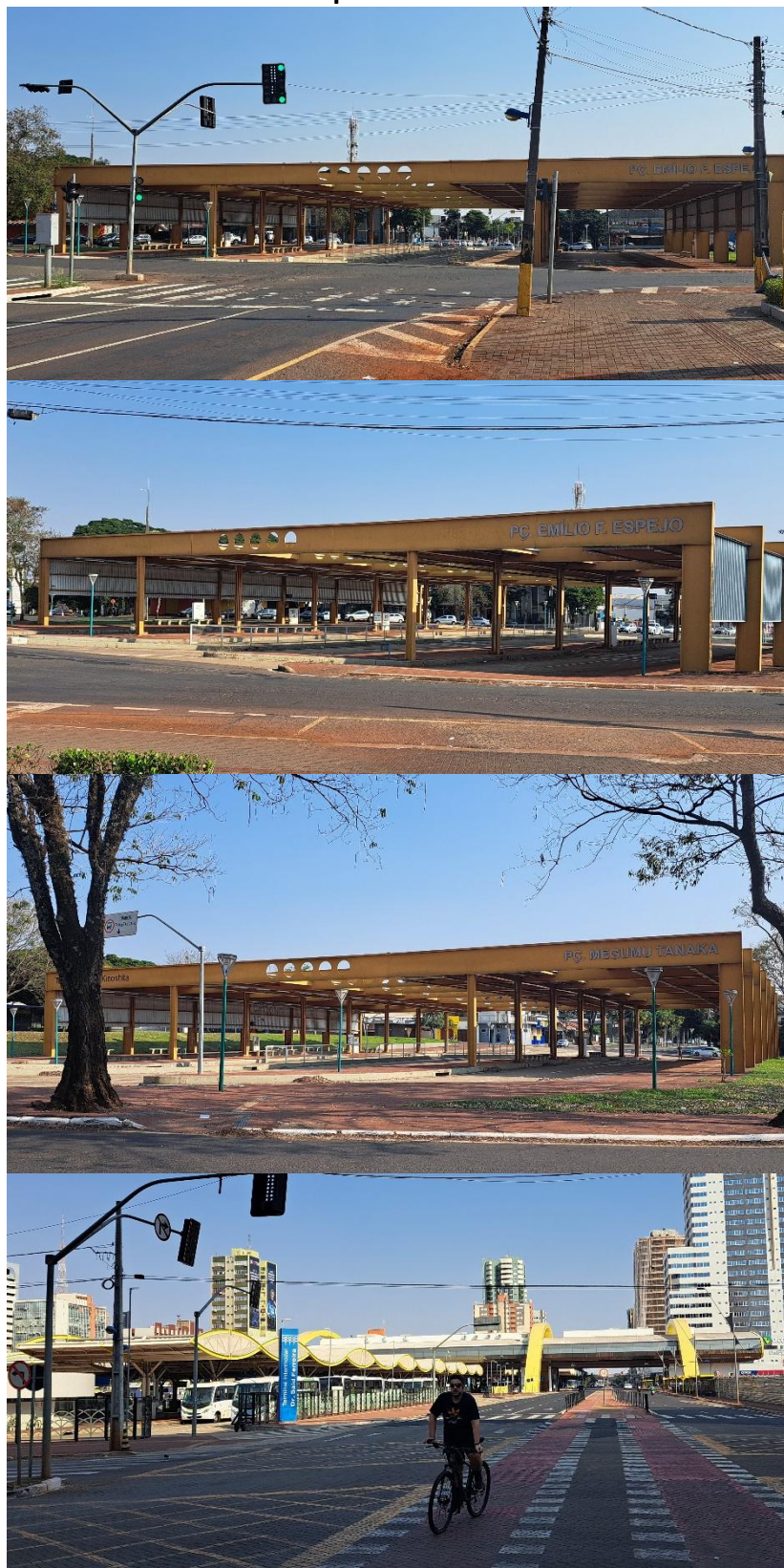
Figura 06: Terminais Ouro Preto, Emílio Fajardo Espejo, Megumu Tanaka e Central, respectivamente
