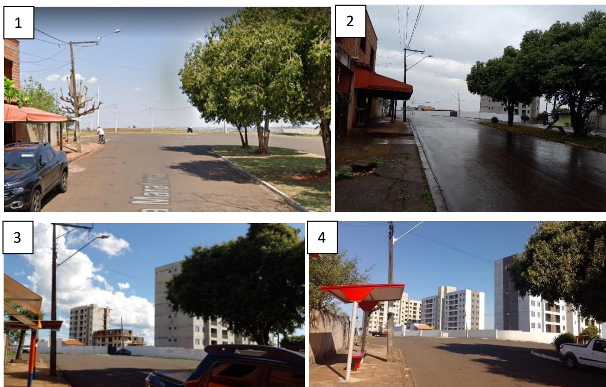
Figura 8: Evolução da construção de um edifício residencial na Avenida da Maratona
