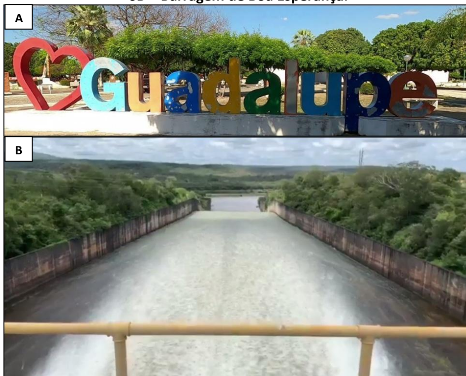
Figura 6: Pontos visitados na cidade de Guadalupe. Figura 6A – Pórtico da cidade de Guadalupe; 6B – Barragem de Boa Esperança.
