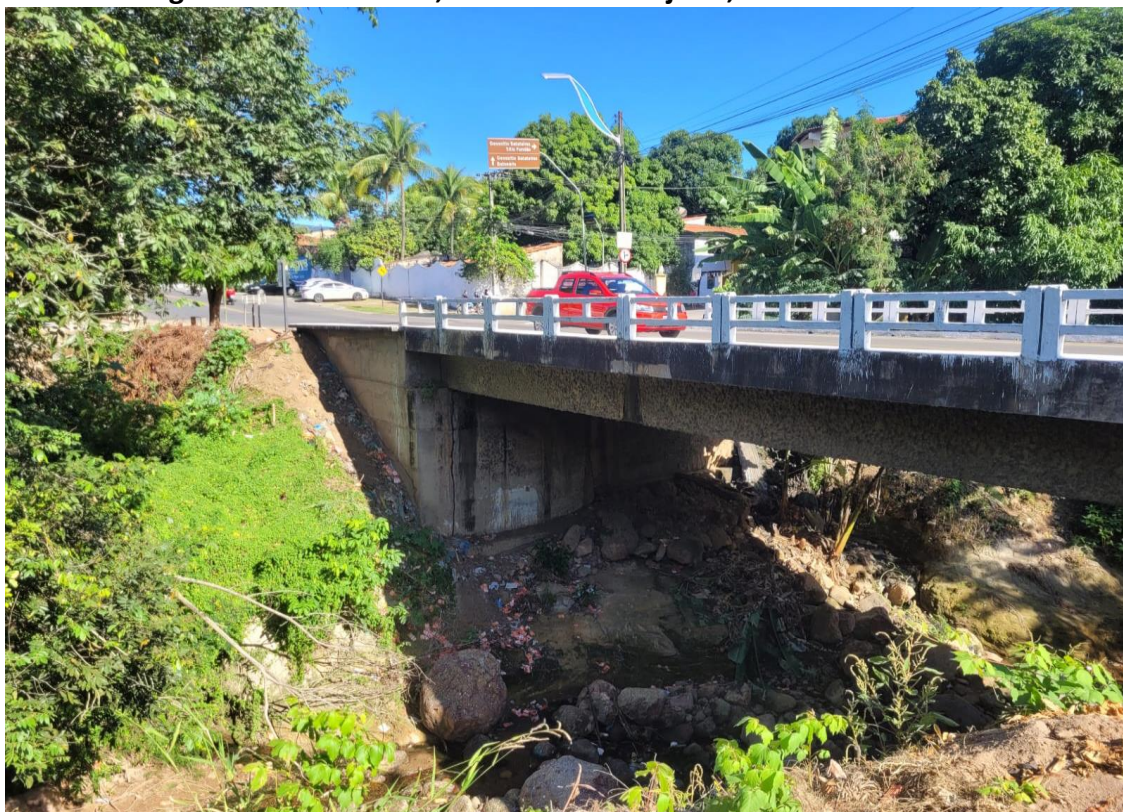
Figura 3: Ponte de Bia, sobre o rio Granjeiro, em Crato no Ceará
