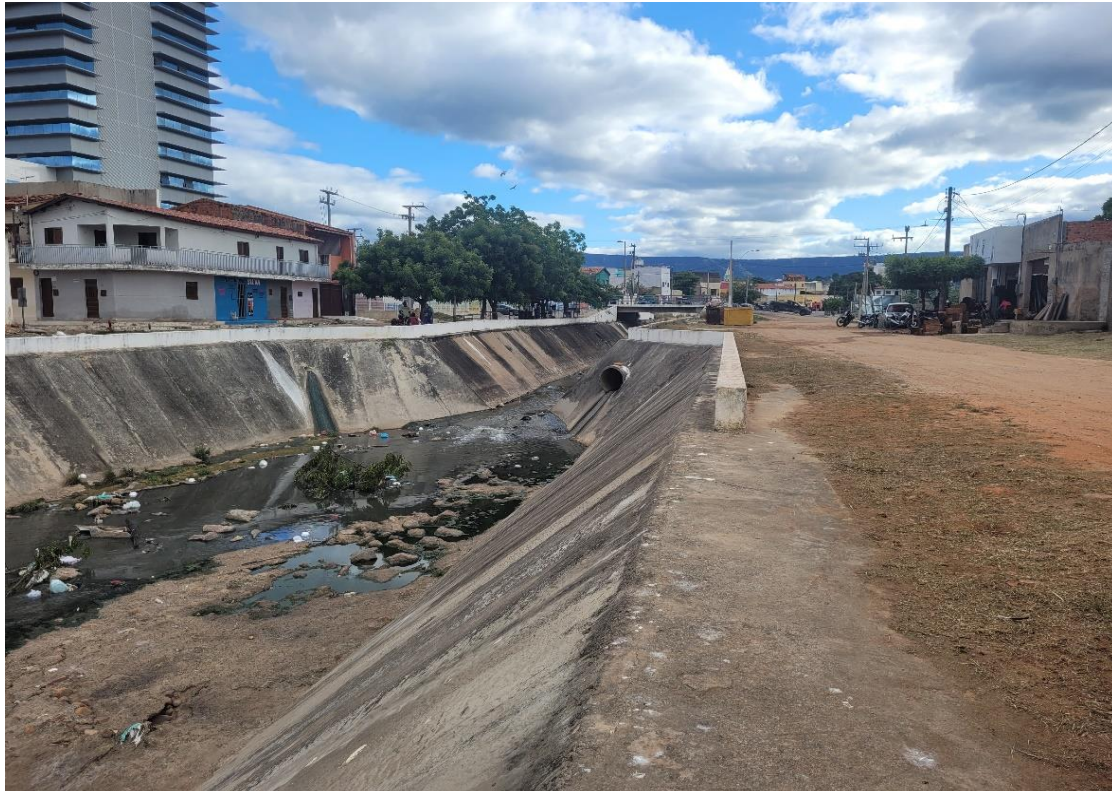
Figura 5: Trecho canalizado do rio Granjeiro, em Crato no Ceará
