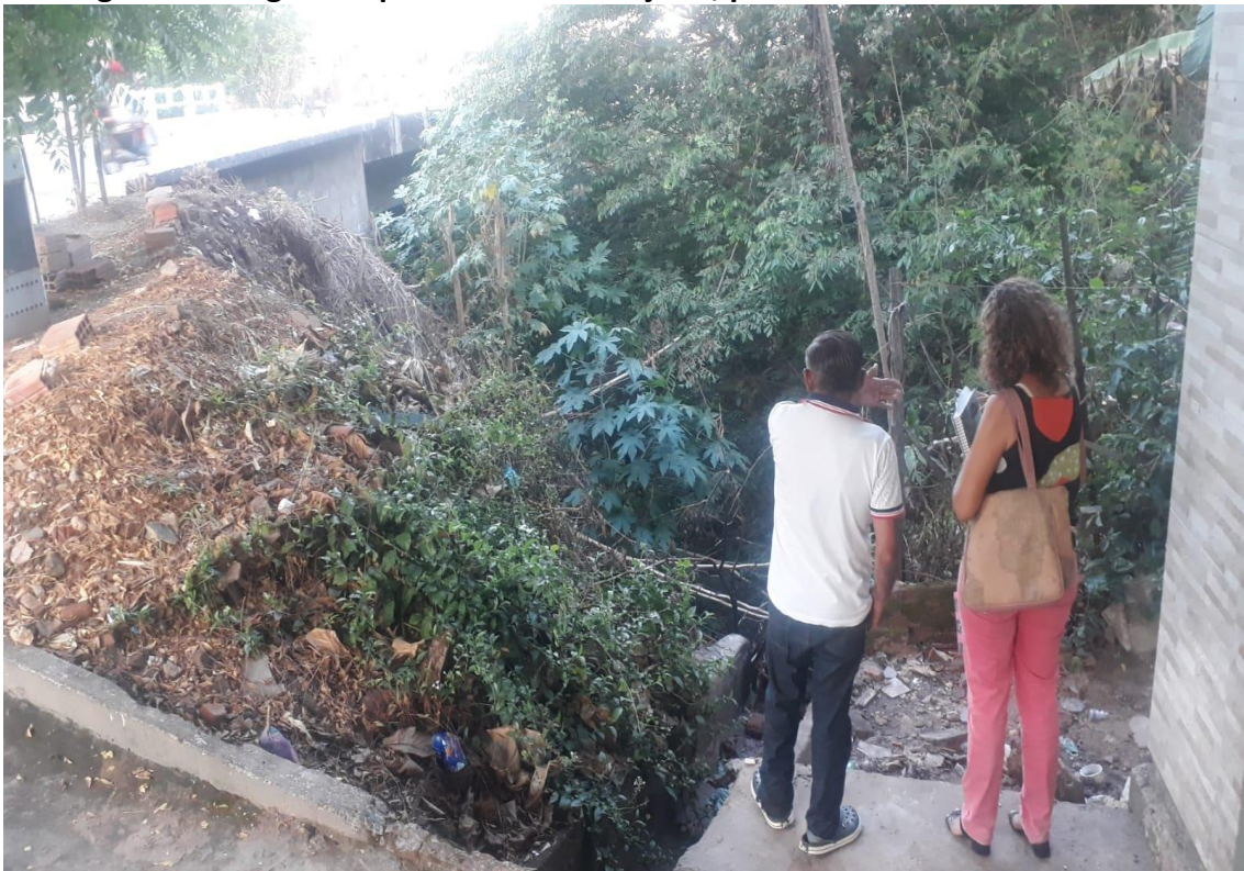
Figura 4: Margem esquerda do rio Granjeiro, próximo a Ponte de Bia
