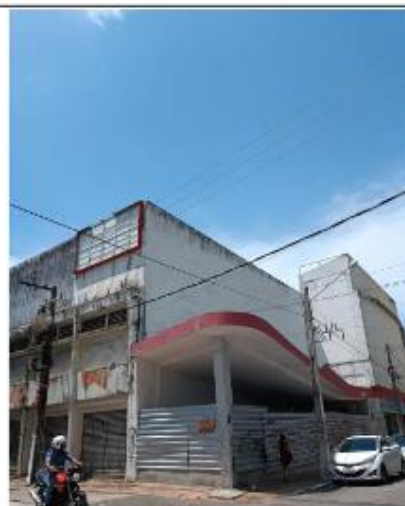
Figura 3: Situação atual do antigo Cine Nordeste
