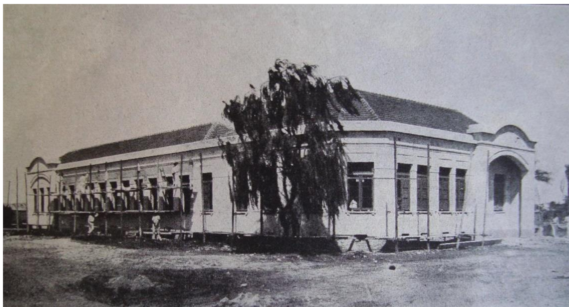
Figura 1: Edifício da Escola de Artes e Offícios em construção
