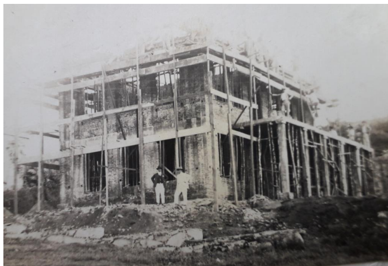
Figura 1: Esqueleto de concreto do primeiro pavilhão
