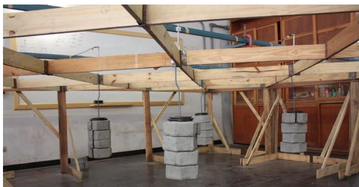
Figura 5 - Detalhe das forças aplicadas em alguns dos nós da estrutura lamelar plana.
