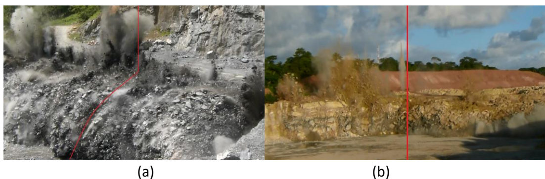
Figura 1: Capturas de tela das filmagens de detonações utilizadas para validar o funcionamento do plugue de tamponamento, onde os mesmos foram instalados apenas na porção direita das bancadas – a) acessório com PEBD e vazado em seu interior; b) acessório com PSAI e com reforço na parte interna.
