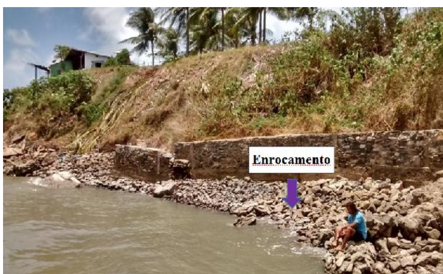
Figura 11: Enrocamento e construção de muros na margem da laguna.
