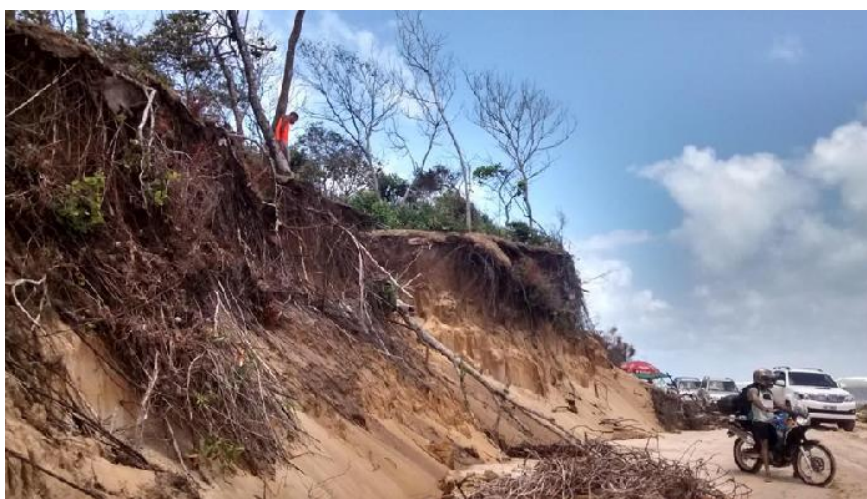
Figura 09: Erosão costeira na escarpa da duna em Senador Georgino Avelino.
