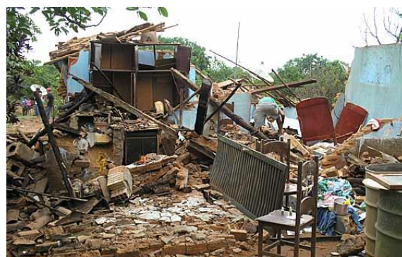
Casa destruída no povoado de Caraíbas
