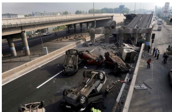
Viaduto, Santiago / Chile, 2010
