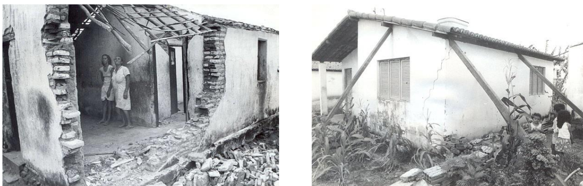
Figura 4: Edificações em João Câmara afetadas pelos sismos de 1986.
