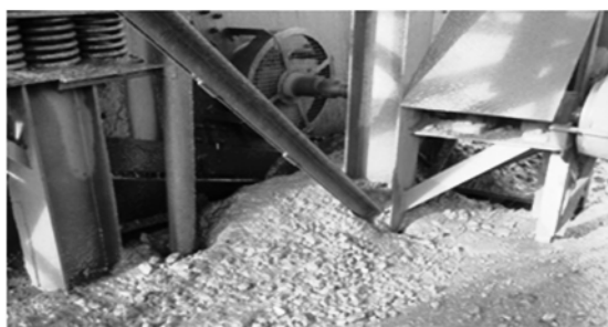
Figura 4 – Transbordo ocasionado por excesso de capacidade no peneiramento secundário.
