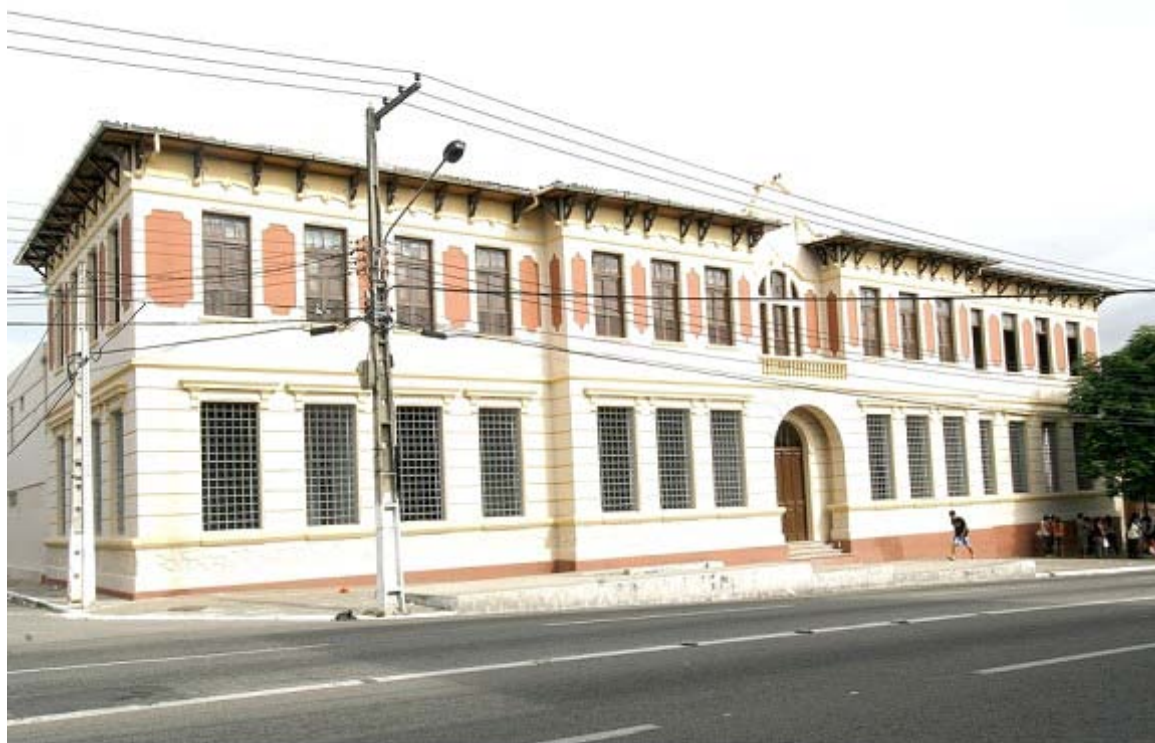
Figura 25 - Fachada da edificação após os trabalhos de reabilitação (agosto de 2009).
