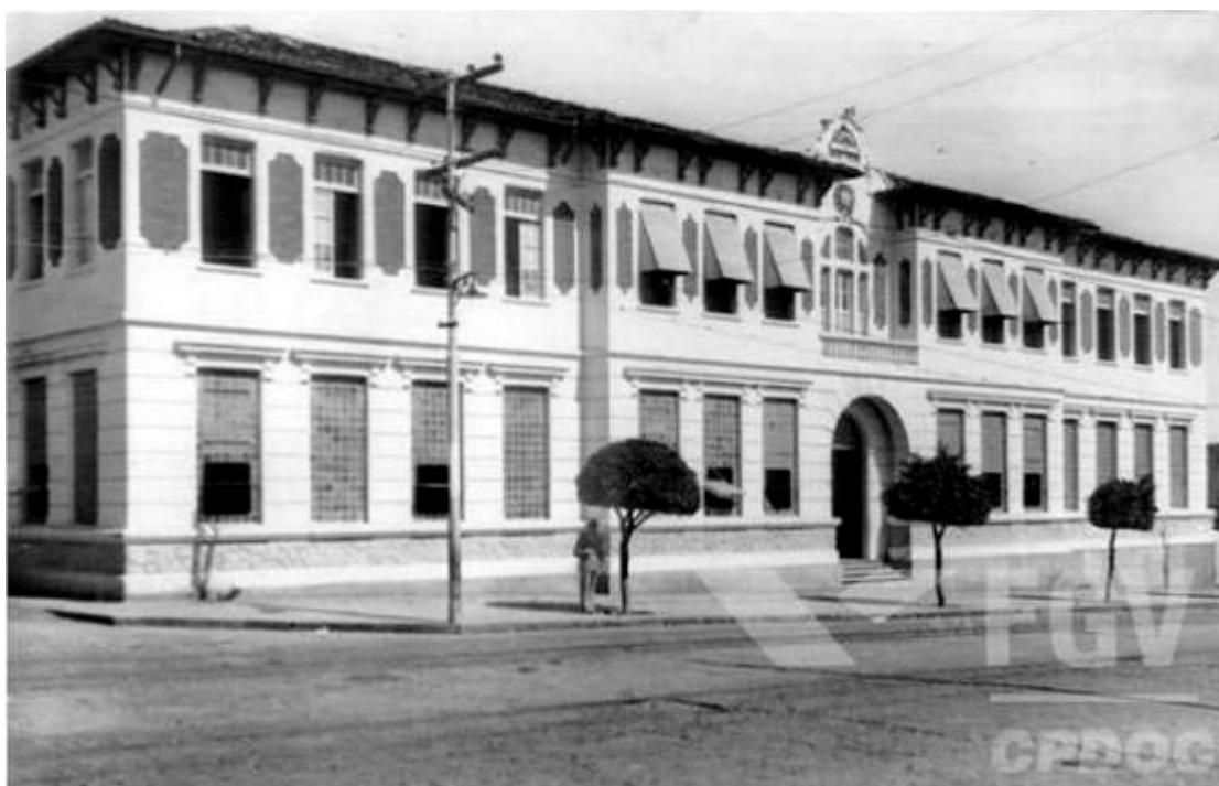
Figura 24 - Fachada original da edificação no início do século XX.
