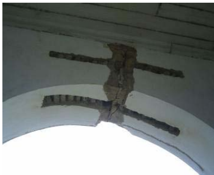
Figura 20 - Colocação de elementos de travamento em arcos plenos de alvenaria.
