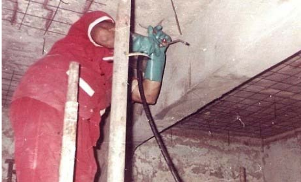
Figura 4 - Aplicação de injeção de resina de epóxi para reforço de viga.
