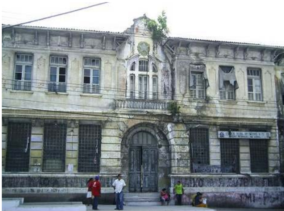
Figura 12 – Aspecto da fachada principal antes do trabalho de reabilitação.
