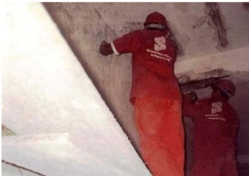
Figura 3 - Retirada do concreto danificado em viga e laje.
