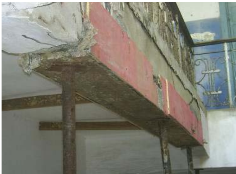
Figura 19 - Recuperação estrutural dos elementos em concreto armado de sustentação da escada de acesso na entrada principal.
