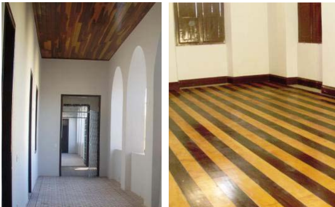
Figura 21 - Pisos em ladrilhos hidráulicos policromados, forro (lambris) e assoalhos em madeira, após trabalhos de recuperação.
