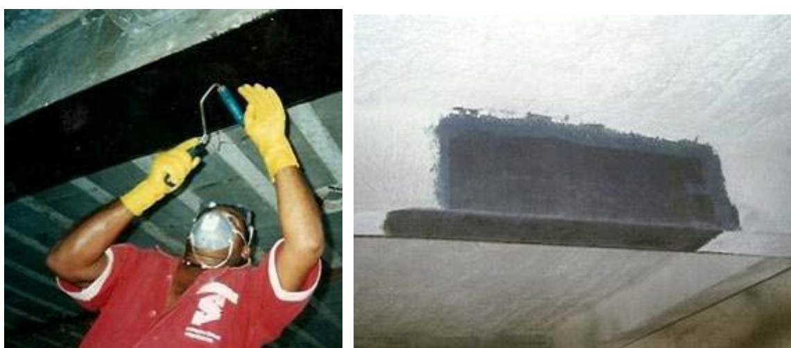
Figura 7 - Aplicação e aspecto final do composto em reforço de viga.
