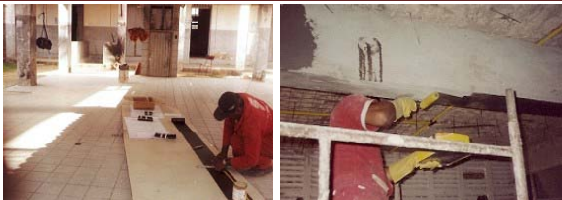
Figura 6 -Preparo da fibra e imprimação de viga.
