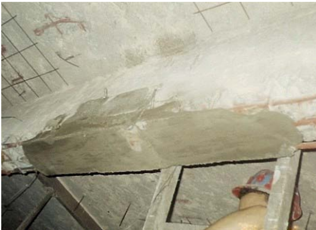
Figura 5 - Aplicação da argamassa para preparo do substrato.
