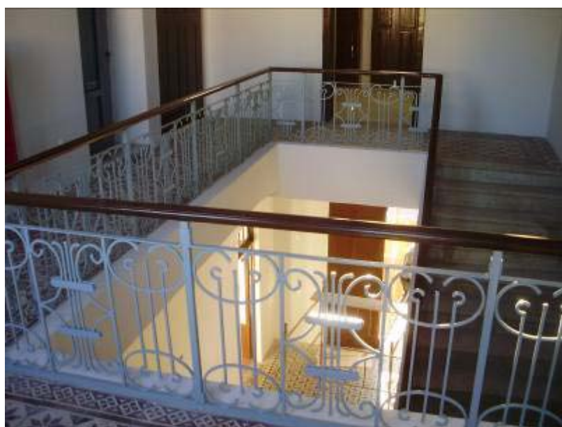
Figura 22 – Restauração de escada de acesso principal ao pavimento superior da edificação.
