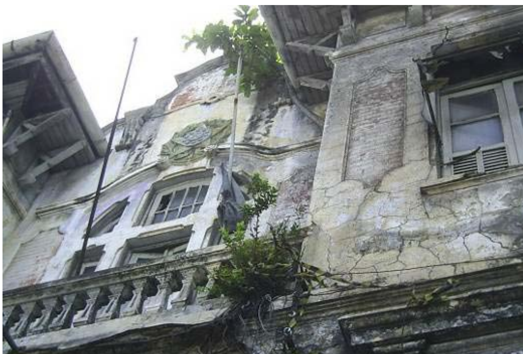
Figura 13 - Detalhe do frontão da edificação antes do início dos trabalhos de reabilitação da construção.
