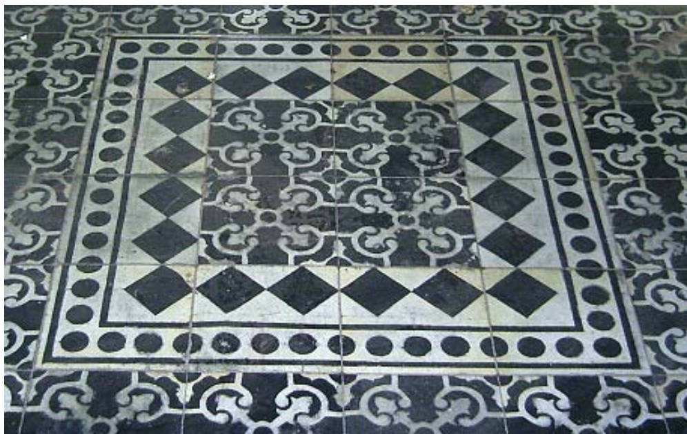
Figura 11 – Detalhe dos ladrilhos hidráulicos policromados.
