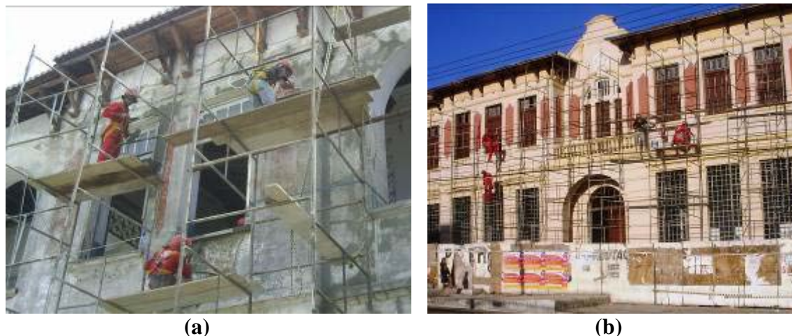
Figura 23 - Execução de trabalhos de reabilitação na fachada da edificação.
