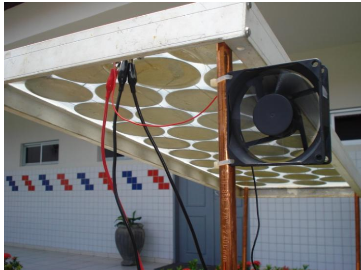
Figura 6 – Sistema solar fotovoltaico montado.
