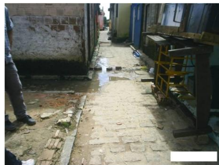
Figura 2 - Água servida lançada em frente as residências.
