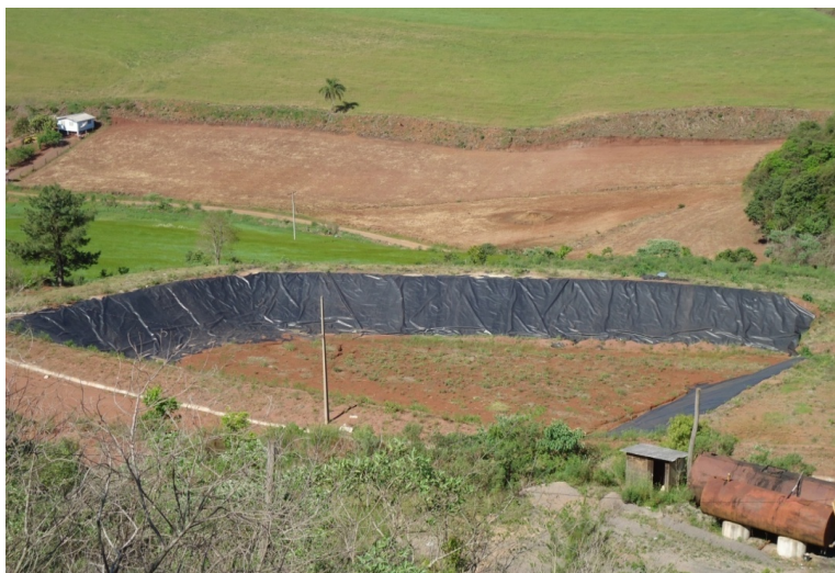
Figura 9: Célula do atual Aterro Sanitário de Sananduva. Fonte autores (2015).
