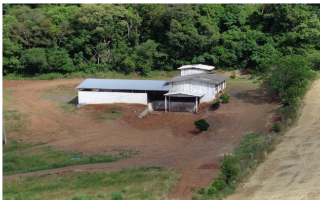
Figura 8: Vista superior da Usina de Triagem atual em fase de readequação. Fonte autores (2015).
