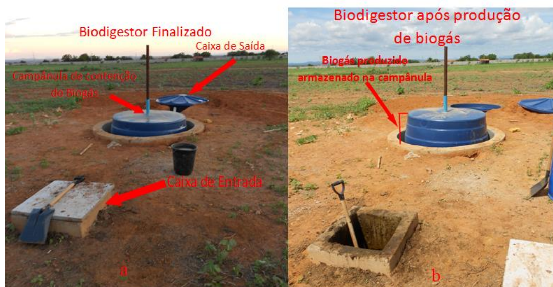
Figura 6 – Biodigestor após ser concluído (a) e em funcionamento após 16 dias do início do abastecimento (b). Fonte: elaborado pelos autores
