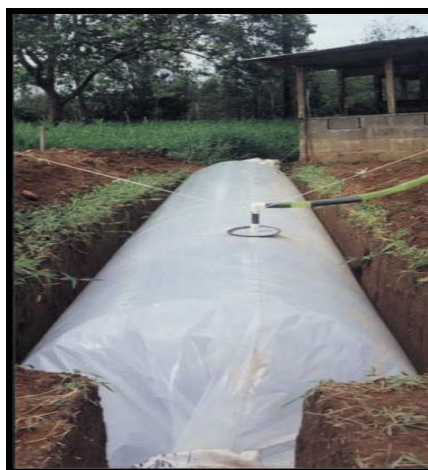
Figura 3: Biodigestor tubular (Pastoral Social, Limón, Costa Rica mencionado por Viquez et al , 2003).
