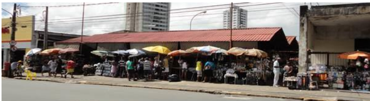
Figuras 01 e 02 : Vistas do pavilhão principal e de um dos pavilhões anexos do Mercado Público de Casa Amarela. Fonte: Arquivo do autor
