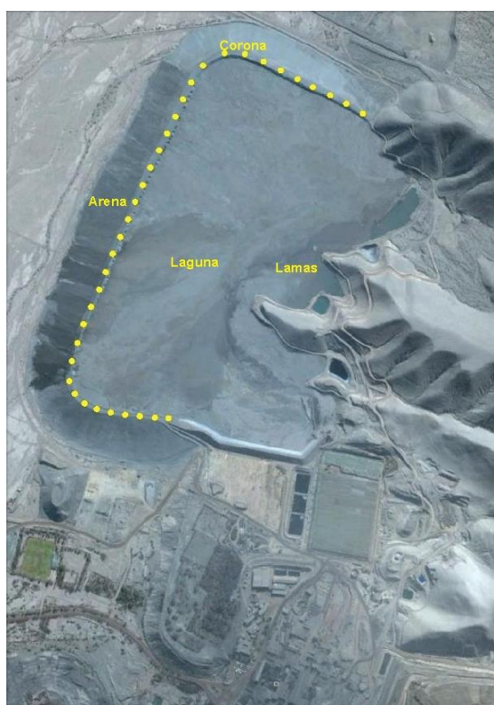
Figura 1. Tranque de relave de planta Matta indicando donde fueron construidas las calicatas
