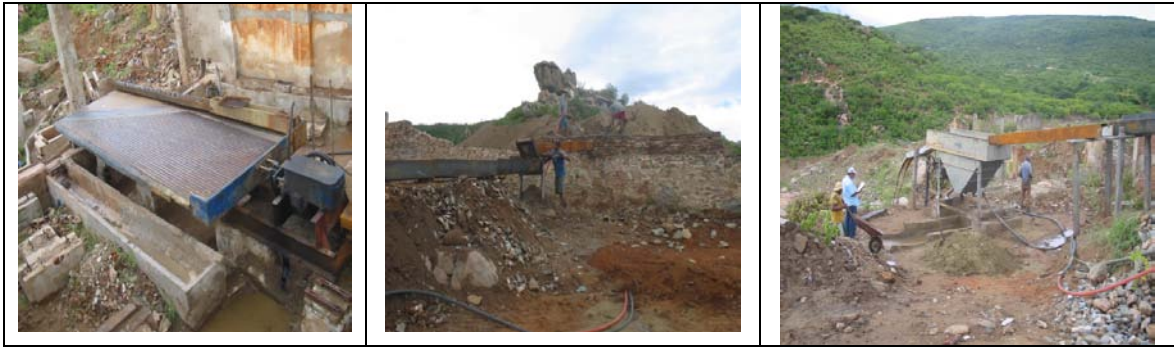
F/igura 3: Instalação de Mesa, Jig para testes com o Tailing da Mina Cafuca.
