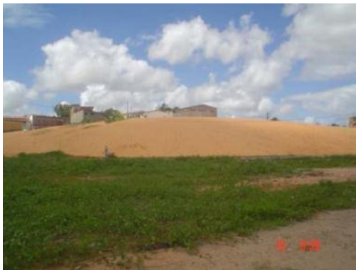
Figura 6: Moradias construídas sobre a duna e vegetação em seu entorno. Fonte: Natal, 2008
