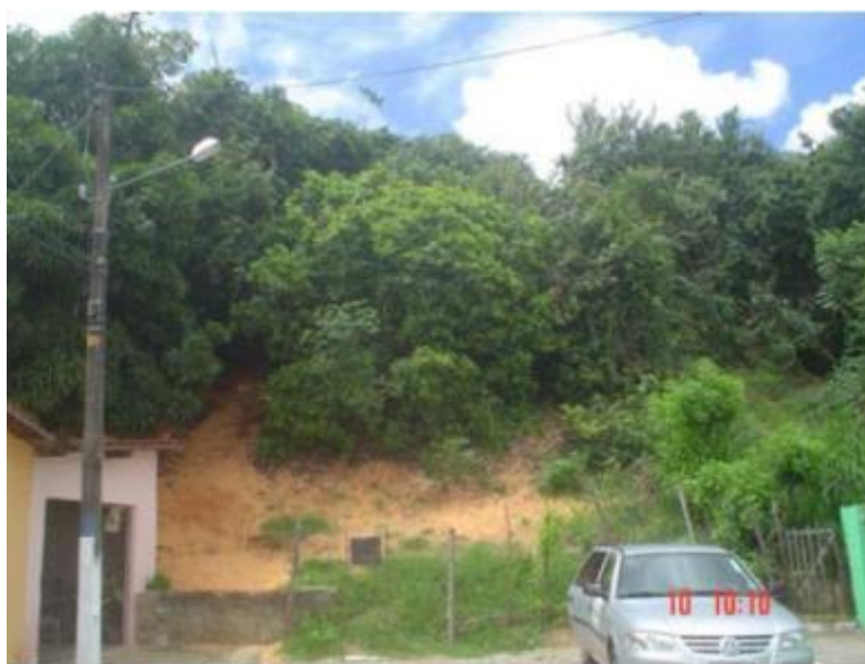
Figura 9: residências construídas em área dunar com risco de deslizamento
