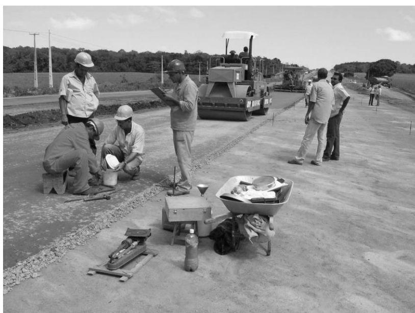
Figura 02: Atuação de técnicos em trabalho de controle de qualidade no campo em trecho da duplicação da BR-101 no RN (DNIT, 2009).
