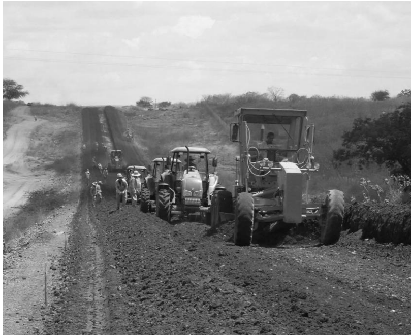
Figura 03: Trecho em execução de terraplenagem na BR-226 no RN (DNIT, 2009).
