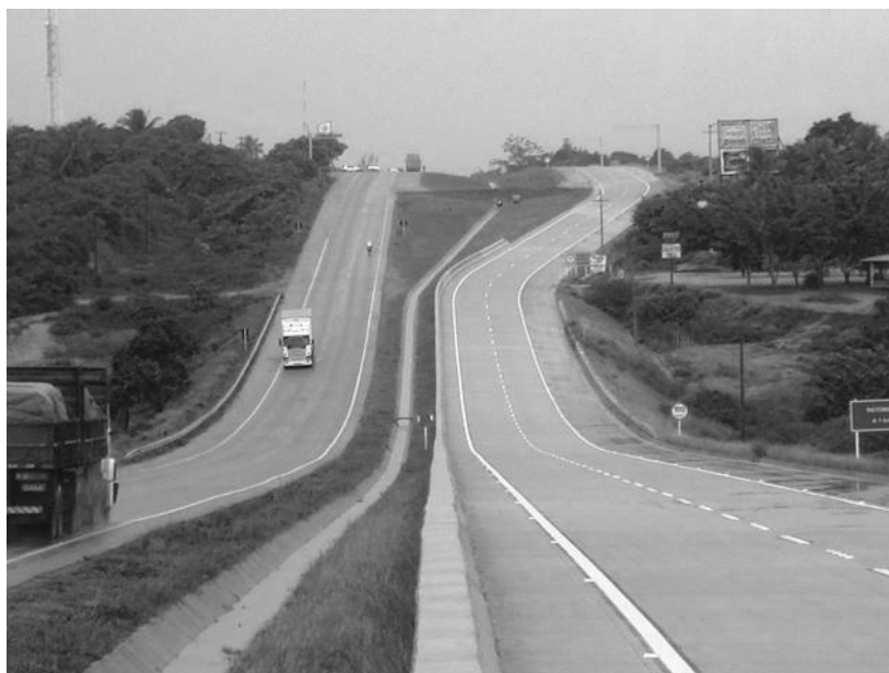
Figura 01: Trecho recentemente duplicado da BR-101 no RN (Fonte: DNIT, 2010).
