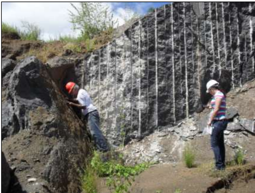
Figura 5 – Vista da face do maciço no terceiro ponto,
