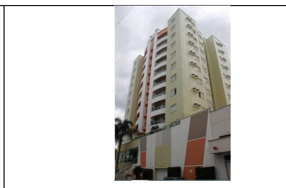
Figura 8: Fachada frontal Sudeste
