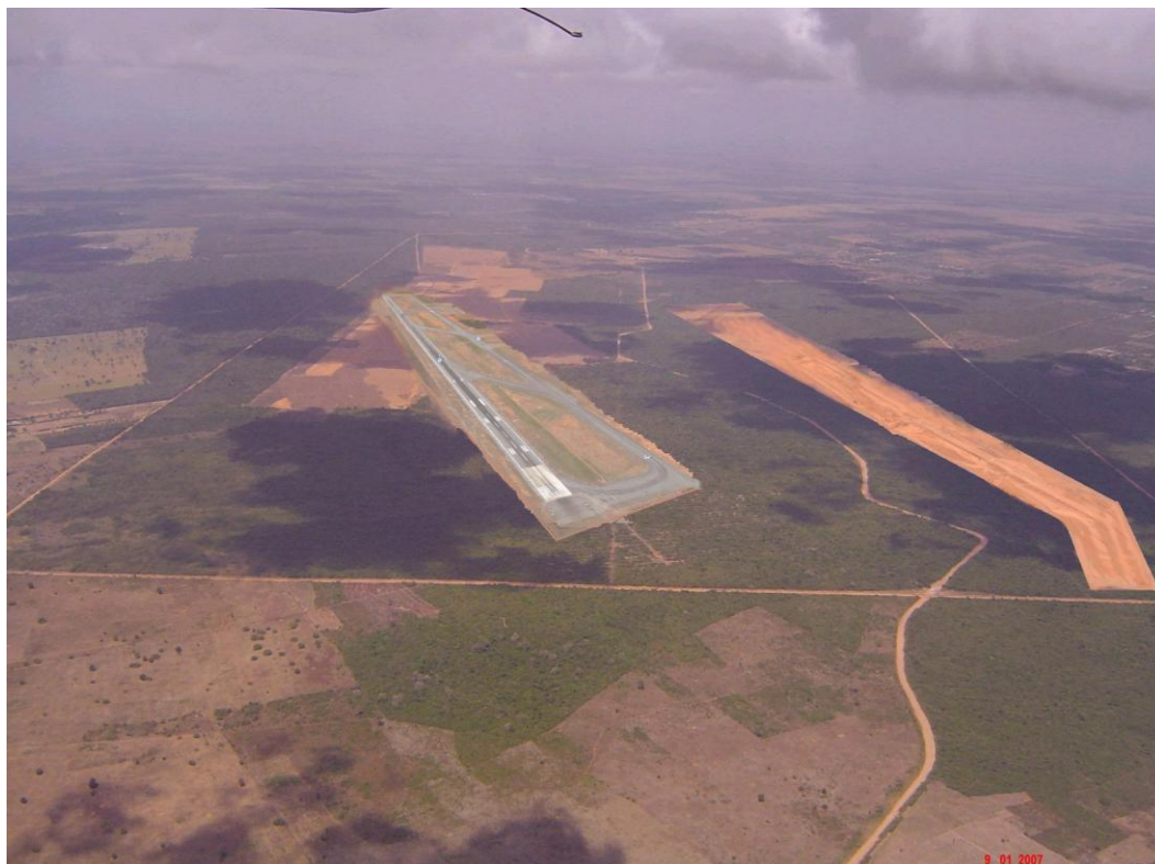
FIGURA 2 – Construção do Aeroporto em andamento.
