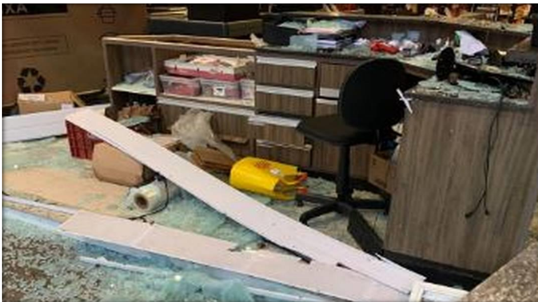
Figura: 53 - Janelas estilhaçadas pelo vento
