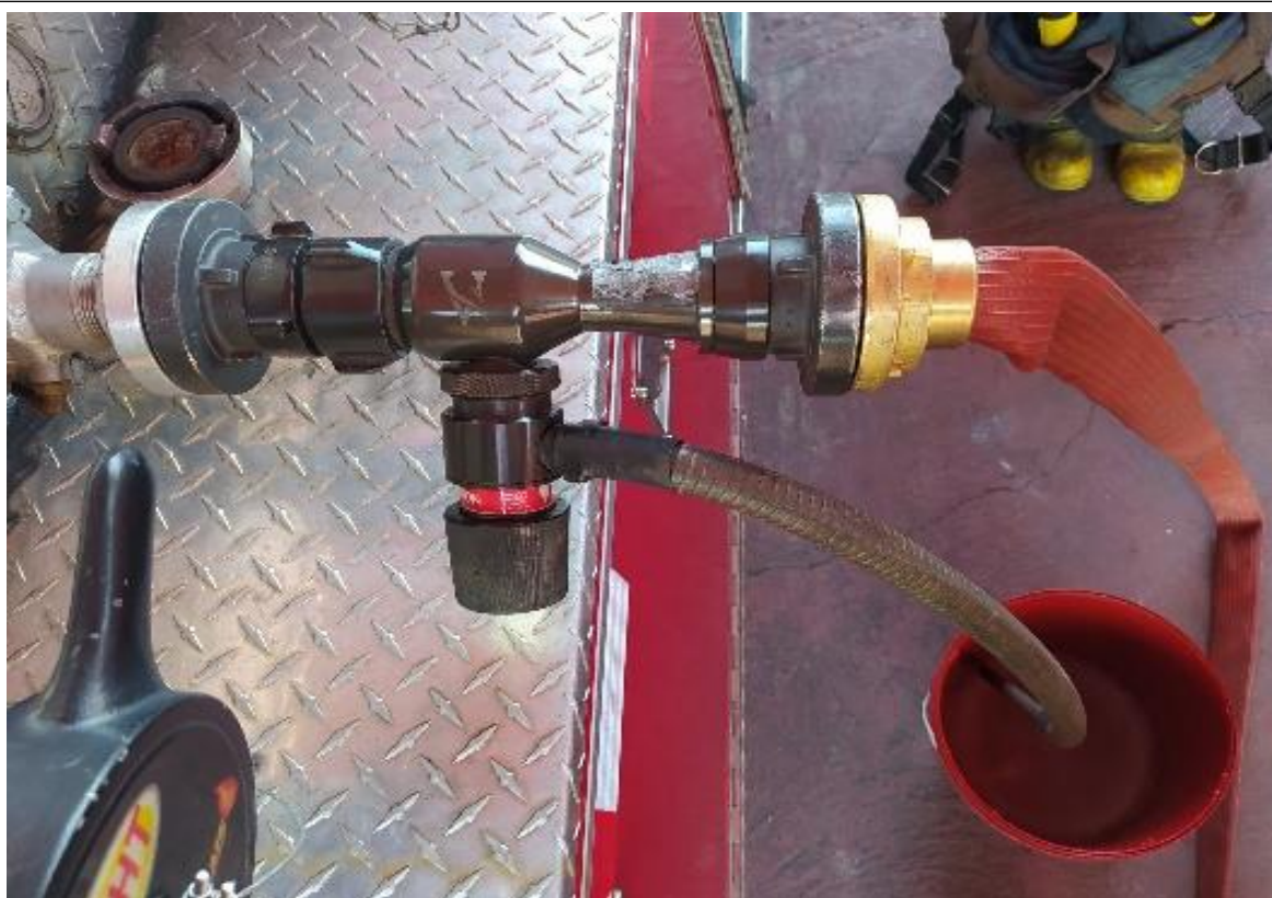
Figura: 101 - Proporcionalizador de espuma, montado direto na expedição do caminhão de incêndio pronto para fazer sucção do LGE. Fonte: Elaborada pelo autor.
