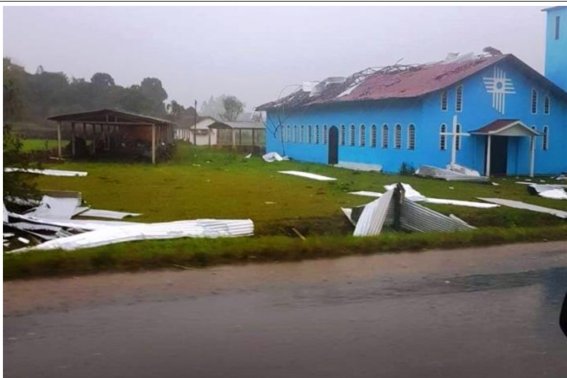
Figura: 51 - Igreja sendo destelhada por ventania
