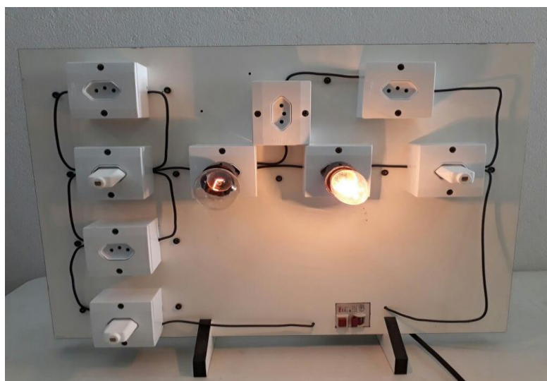
Figura 3: Painel elétrico com montagem para circuito em série com duas lâmpadas Fonte: Arquivo pessoal do autor.
