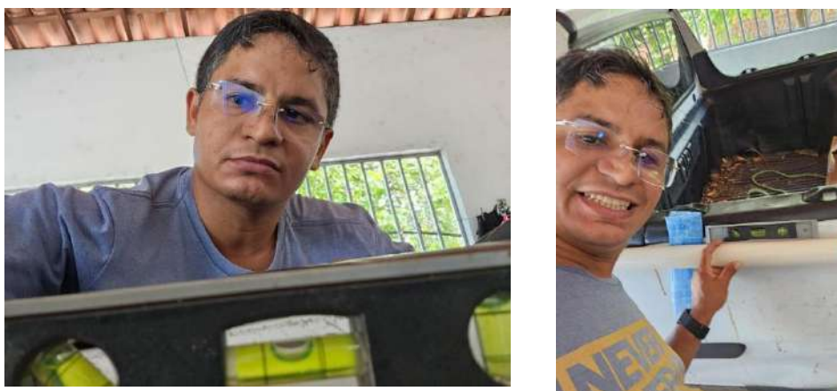
Figura 4 – Colocação dos tecidos e verificação do nivelamento do cano
