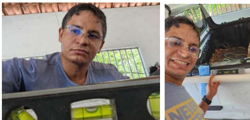
Figura 18 - Colocação dos tecidos e verificação do nivelamento do cano
