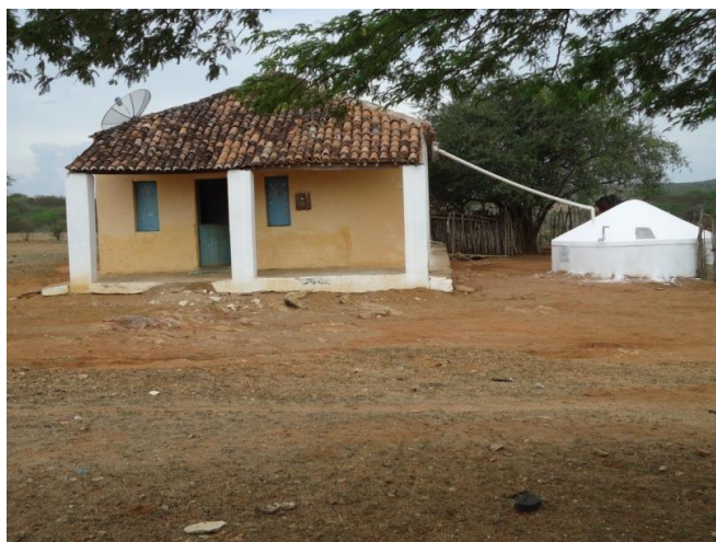
Figura 1 - Cisterna de placa em moradia do assentamento Serra do Monte. Fonte: Pesquisa de campo, novembro de 2014.
