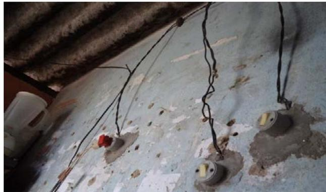
**Figura 14- Detalhe do risco de choque elétrico na residência 07 do bairro Coqueiros.**
