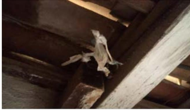
Figura 16: Detalhe do risco de choque elétrico na residência 02 do bairro Barreiro.
