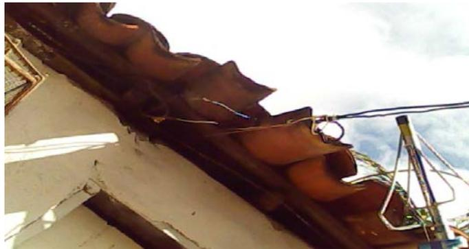
Figura 7: Detalhe do risco de choque elétrico na residência 04 do bairro Novo São Gonçalo.
