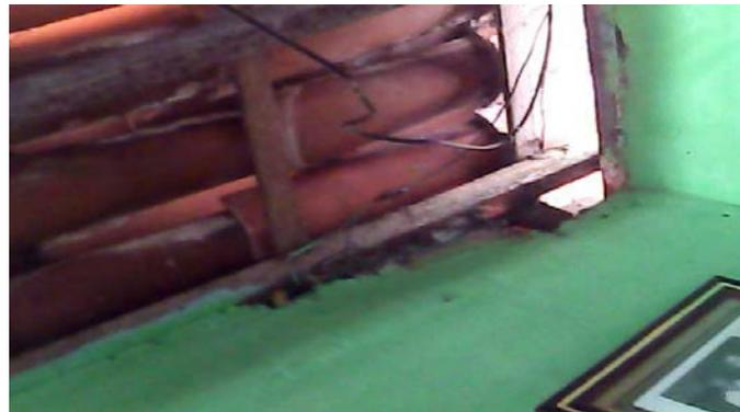
**Figura 15: Detalhe do risco de choque elétrico na residência 01 do bairro Barreiro.**
