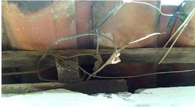
Figura 6: Detalhe do risco de choque elétrico na residência 04 do bairro Novo São Gonçalo.
