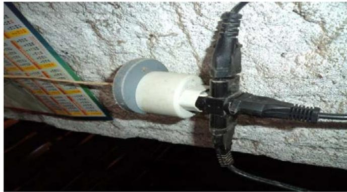
Figura 17: Detalhe do risco de choque elétrico na residência 03 do bairro Barreiro.
