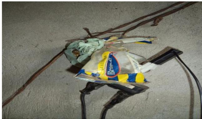
Figura 9: Detalhe do risco de choque elétrico na residência 02 do bairro Coqueiros.
