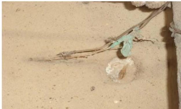
Figura 10: Detalhe do risco de choque elétrico na residência 03 do bairro Coqueiros.
