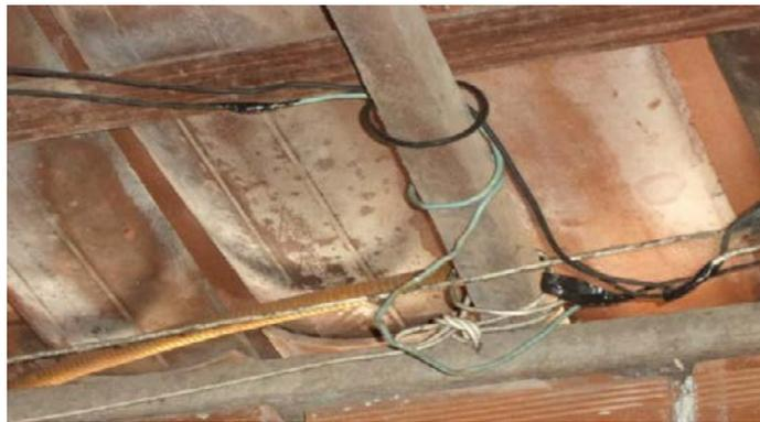
Figura 2: Detalhe do risco de choque elétrico na residência 01 do bairro Novo São Gonçalo.
