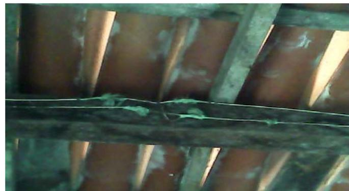
Figura 5: Detalhe do risco de choque elétrico na residência 03 do bairro Novo São Gonçalo.
