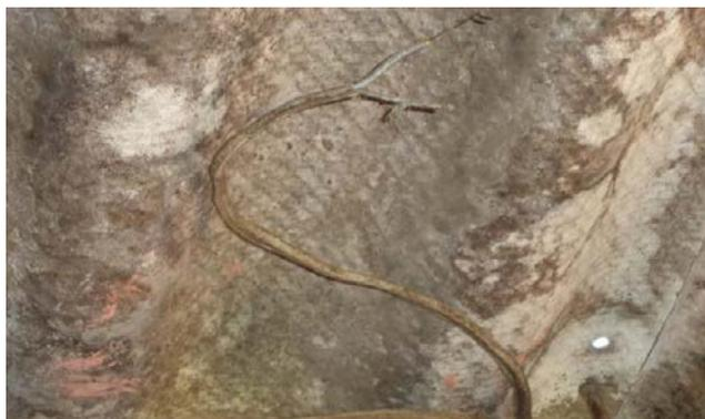
Figura 12: Detalhe do risco de choque elétrico na residência 05 do bairro de coqueiros.
