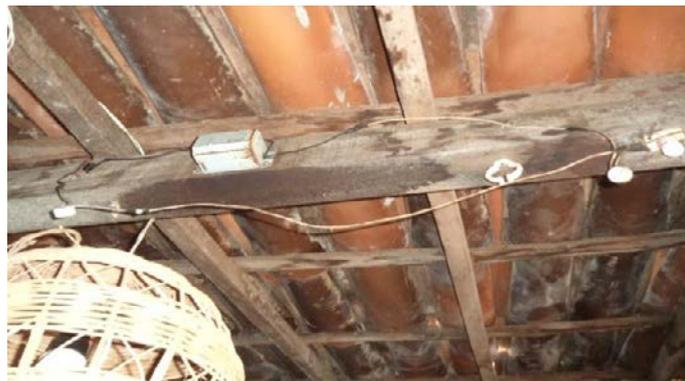
Figura 3: Detalhe do risco de choque elétrico na residência 02 do bairro Novo São Gonçalo..
