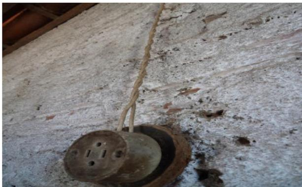
Figura 11: Detalhe do risco de choque elétrico na residência 04 do bairro Coqueiros.
