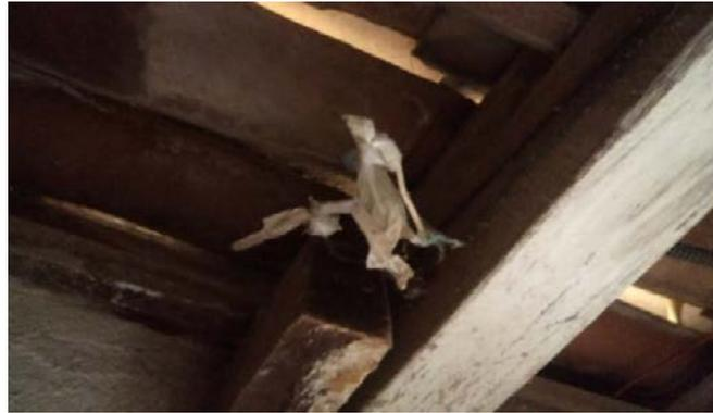
**Figura 13: Detalhe do risco de choque elétrico na residência 06 do bairro Coqueiros.**
