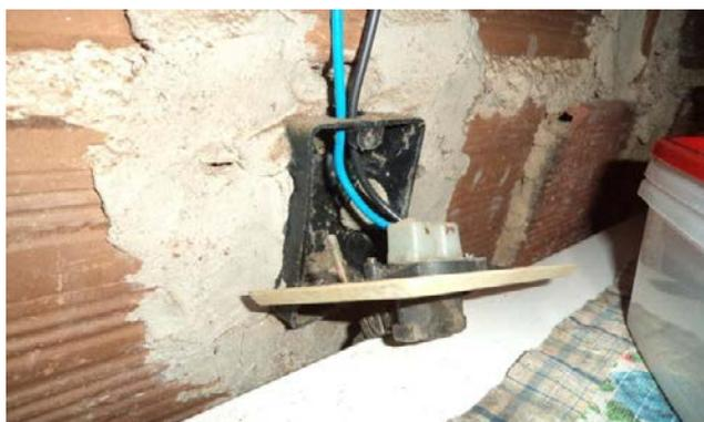
Figura 1: Detalhe do risco de choque elétrico na residência 01 do bairro Novo São Gonçalo.
