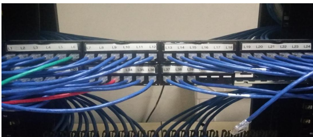
Figura 33: Patch panel responsável pelo espelhamento da rede local.
