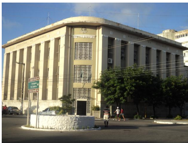
Figura 1: Prédio do Ministério da Fazenda, Ribeira - Natal – RN, onde fica o SERPRO
